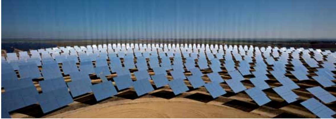
Izquierda y derecha Abengoa PS10. Primera torre solar termoeléctrica instalada en el mundo. Sanlúcar la Mayor. Sevilla.
