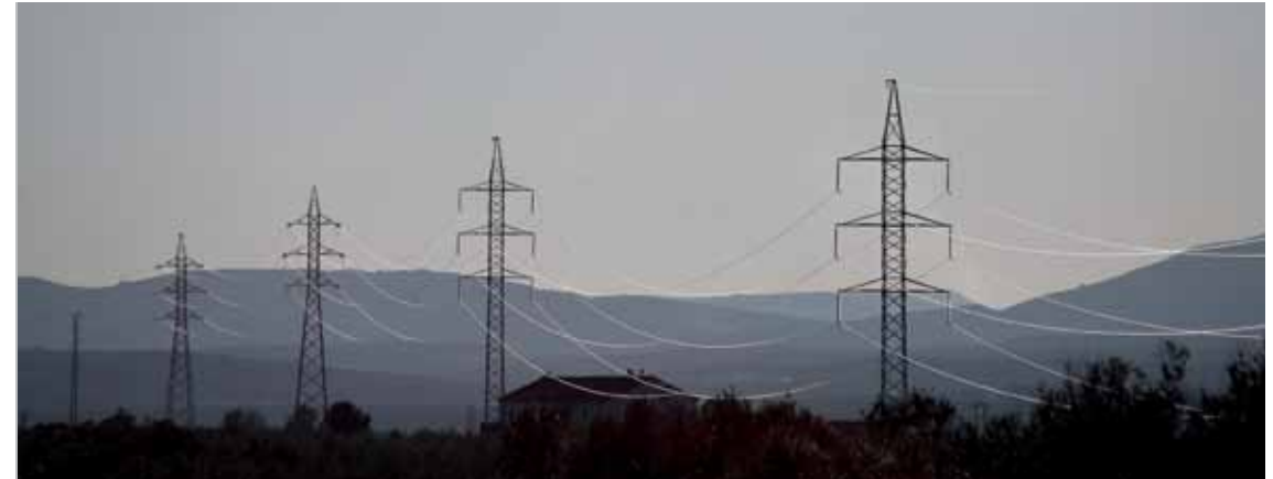
Tendido eléctrico en Puente de Génave. Jaén.
